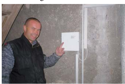
ZDENĚK ŠIMEK, jeden z jednatelů firmy Allos, ukazuje zdroj pro napájení čidel zabezpečovacího systému. Foto: PAVEL ZEMAN
